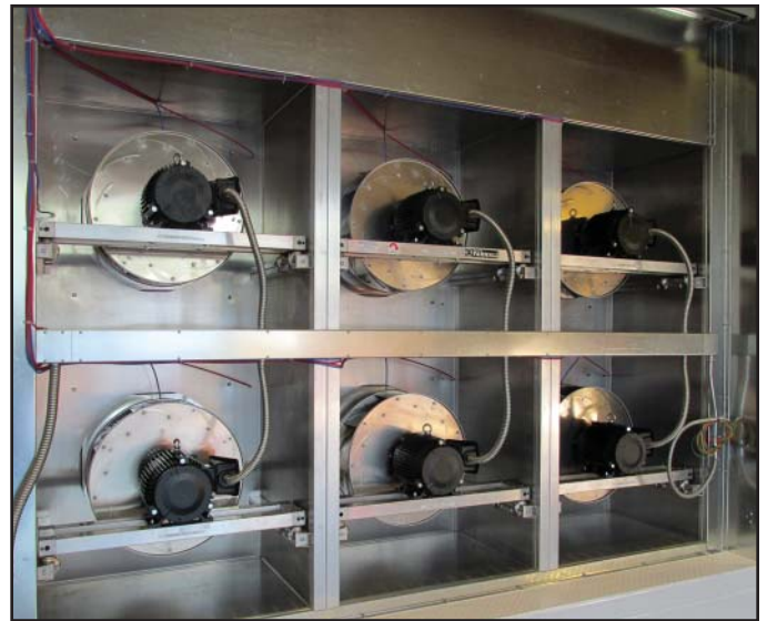
FAN / MOTOR ARRANGEMENT
