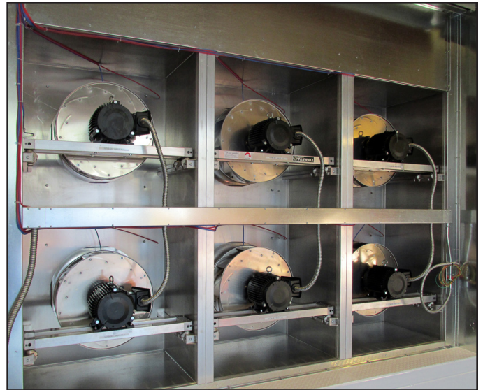
FAN / MOTOR ARRANGEMENT
